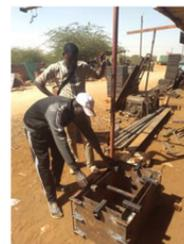
Fabrication du moule pour la préfabrication du module de prétraitement par un artisan local
