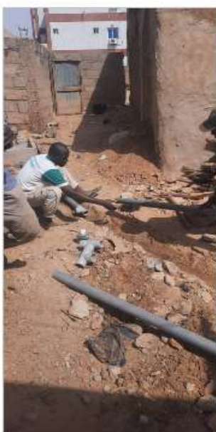
Pose des conduites
