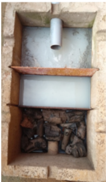
Bac décanteur fabriqué par les maçons
